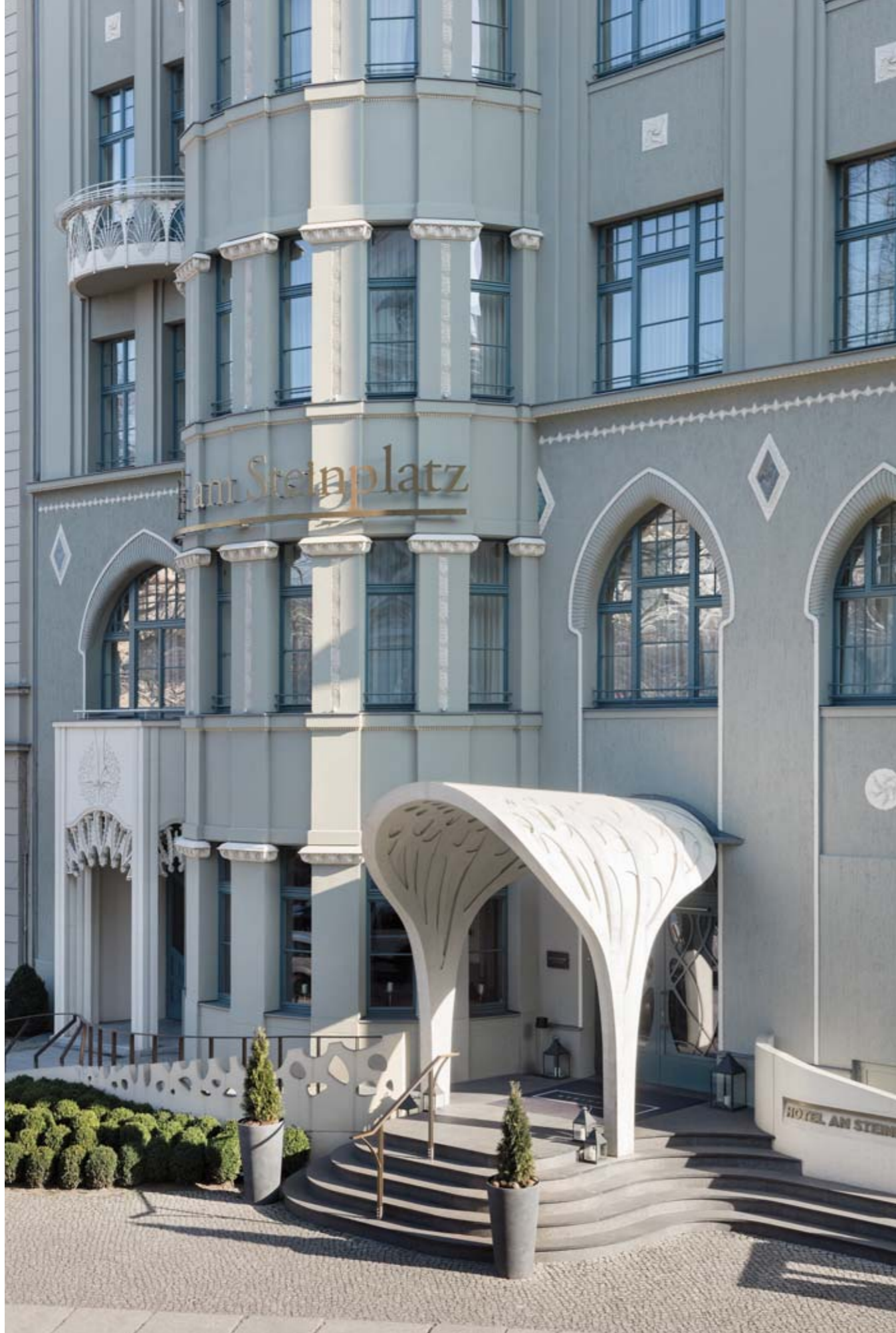
Die historischen Fassadenfarben wurden analysiert und ein Farbkonzept für die Rekonstruktion im Zusammenspiel mit den Neubau-Elementen entwickelt.
